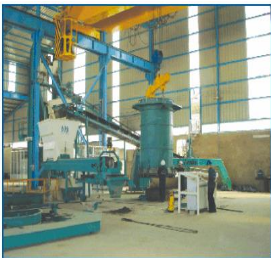
Đặt khuôn công vào chỗ rung
