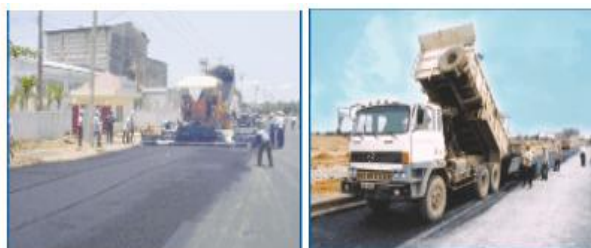
Thi công thảm BTNN mặt đường
