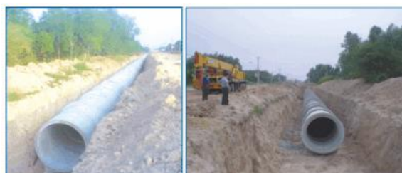
Công trình GTTL
