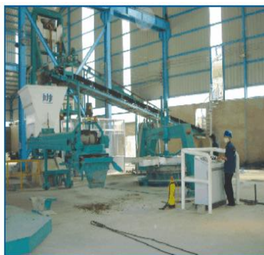
Quá trình rung công tròn JUMBO
