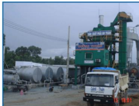
Trạm bê tông nhả nóng
